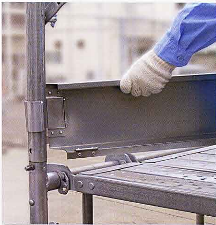
①フラットな面を外側にして、左側の固定金具を建わく支柱に掛けます。
