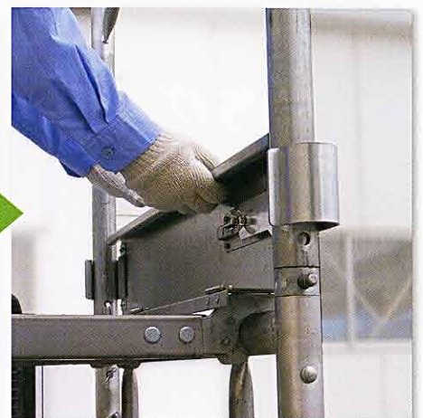
③右側の固定金具が建わく支柱に掛かる位置にします。
