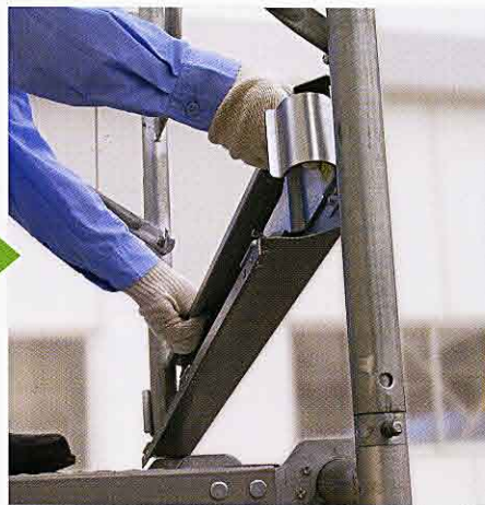
②右側を少し持ち上げ、建わく支柱をかわします。
