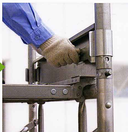
⑤蝶ナットを締め固定します。
